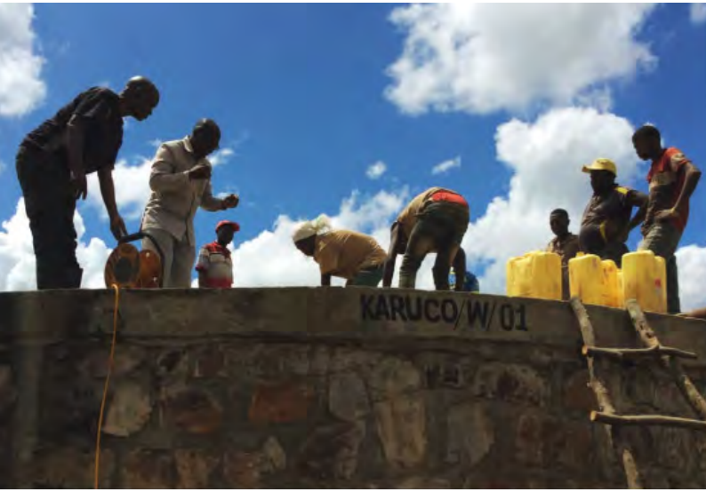
Sanierungsarbeiten an der Zisterne
